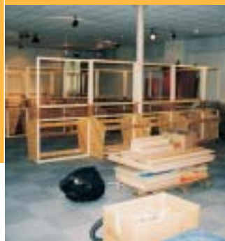
Montage de la structure portante
